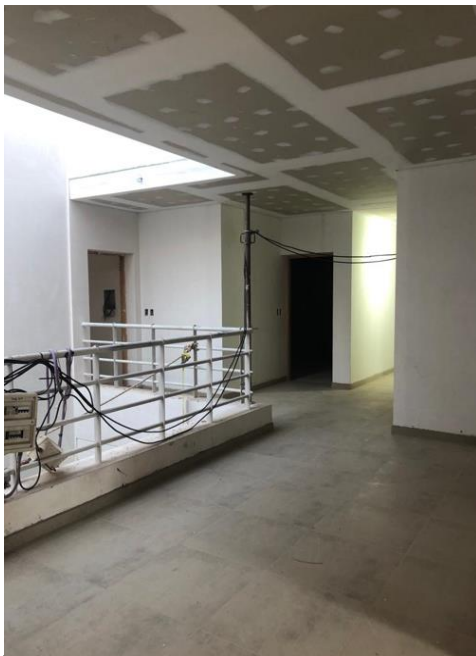
Colocación placas de roca de yeso en cielorraso
