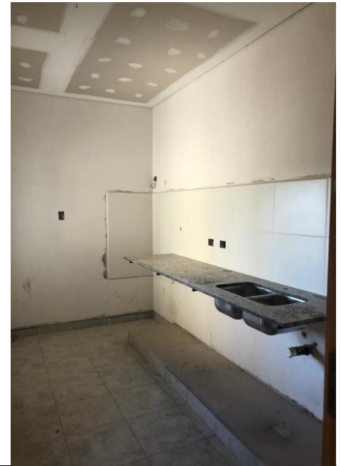
Colocación de pisos
